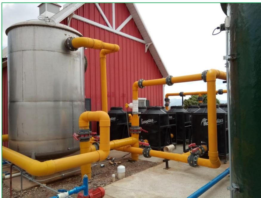
**Figura 2.** Sistema de eliminación de H<sub>2</sub>S empacado con nanomateriales magnéticos producidos mediante la técnica de co-precipitación química instalado en la AGL Agrícola Ganadera Los Luján, Delicias, Chihuahua, México.
